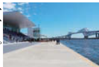
▲今年完成した海の森水上競技場
