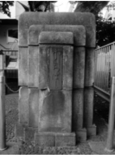
和倉橋親柱 2基 (富岡1 江東区)
