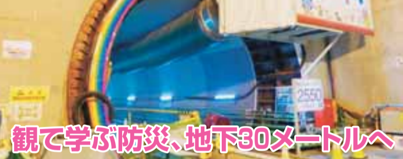
▲地下約30mの工事中の下水道管内部を見学
