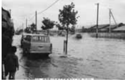
▲昭和38年6月の台風被害(南砂町周辺)
