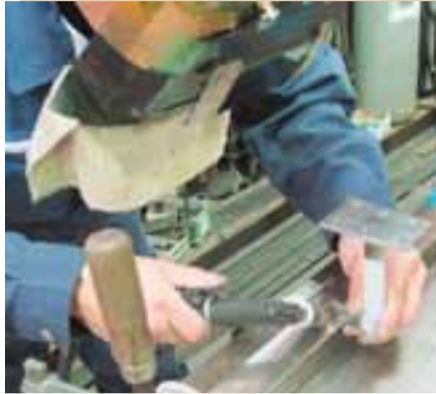
▲職人による溶接作業
