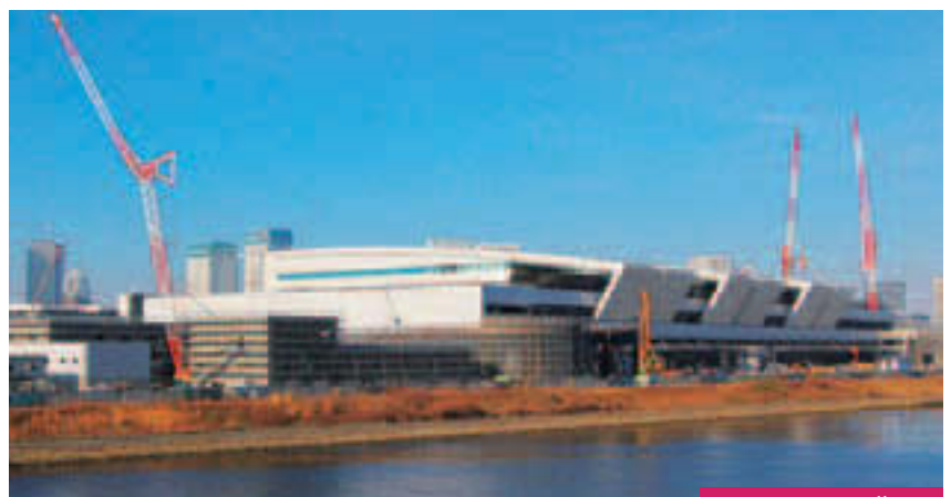
▲開場に向け工事が進む豊洲市場
