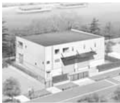
▲8月に完成予定の中央防災倉庫
