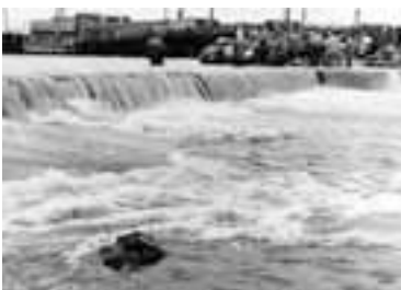
▲台風11号(昭和33年)で決壊した中川堤防(亀戸9丁目)
