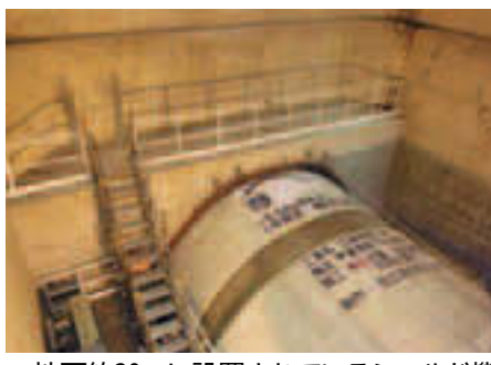
▲地下約30mに設置されているシールド機
