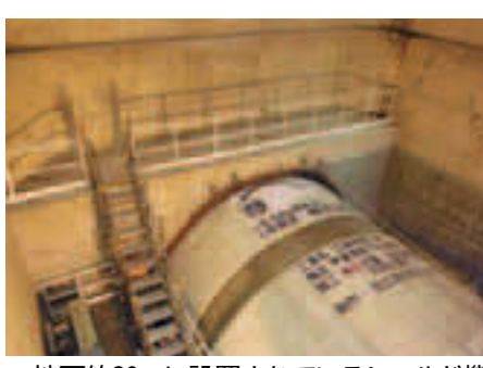
▲地下約30mに設置されているシールド機
