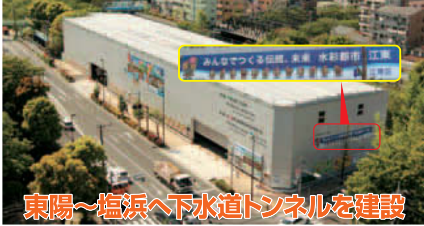
▲工事始点に設置された全長約100mの防音ハウス(側面には区のPRも掲載)
