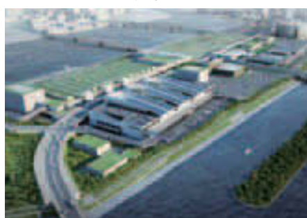
▲広大な敷地を有し、首都圏の基幹市場として整備される豊洲新市場
