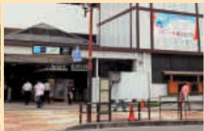
▲新木場駅駅舎壁面
