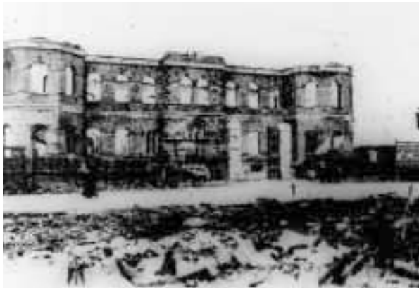
▲深川区役所焼跡
