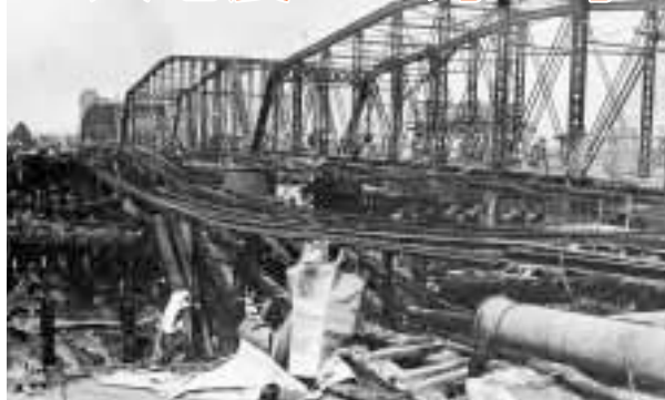
▲永代橋の火害[写真提供:国立科学博物館]
