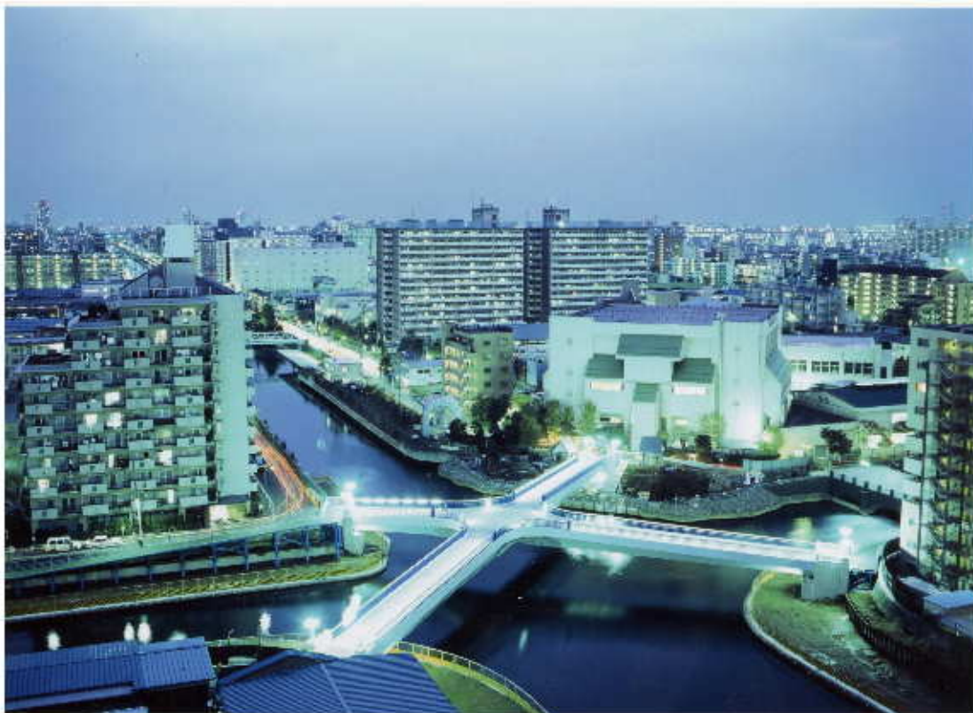
小名木川クローバー橋
