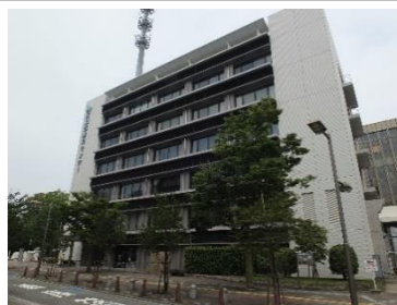
■防災センター
