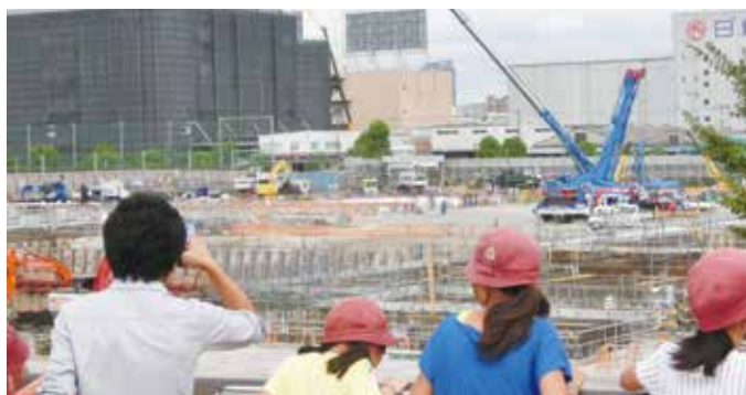
東京アクアティクスセンター工事見学
