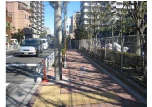
歩道の段差改修工事
