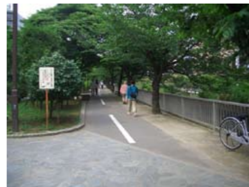
仙台堀川公園の園路の改修
