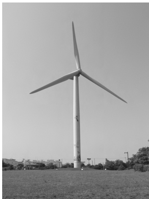
若洲風力発電施設
