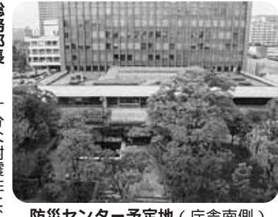
防災センター予定地 (庁舎南側)
