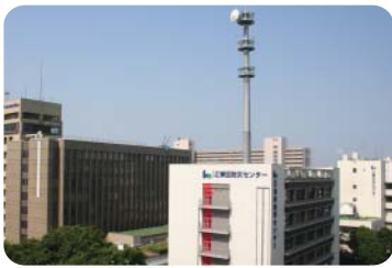
防災センター
