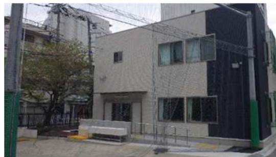
【きッズクラブ・地域集会室棟新築(外観)】
