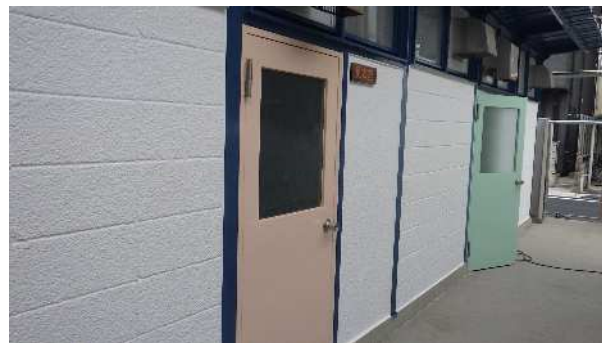
【プール更衣室(外壁)】
