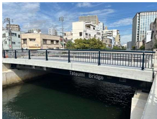
(竣工済み橋梁：巽橋)
