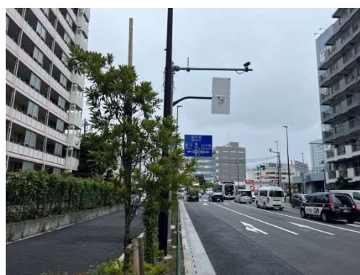
(補助第 116 号線 左：整備前、右：整備後)
