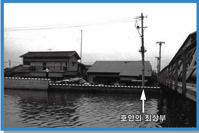
왼 쪽: 만조 시, 호안의 최상부 근처까지 물이 차 오른 오나기강. 왼쪽은 증축한 새 호안, 1970년 9월 30일 오른쪽: 1938년에 판 우물, 지반 침하로 인해 기존 설치 지반면보다 현재 지반면이 낮습니다(가쓰시카구 히가시신코이와 1초메) 제공: 도쿄도 제5건설사무소
