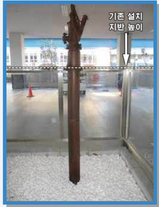
왼 쪽: 만조 시, 호안의 최상부 근처까지 물이 차 오른 오나기강. 왼쪽은 증축한 새 호안, 1970년 9월 30일 오른쪽: 1938년에 판 우물, 지반 침하로 인해 기존 설치 지반면보다 현재 지반면이 낮습니다(가쓰시카구 히가시신코이와 1초메) 제공: 도쿄도 제5건설사무소
