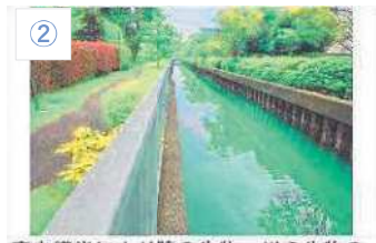
② 直立護岸により陸の生物、川の生物の行き来は困難。浅い水辺を好む生物はすめない。人間も水に触れられない。
