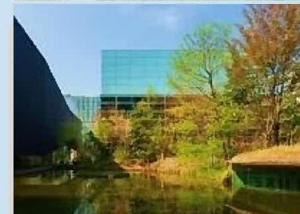
再生の杜(清水建設)
