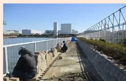
潮風の散歩道(汐見・工事中)
