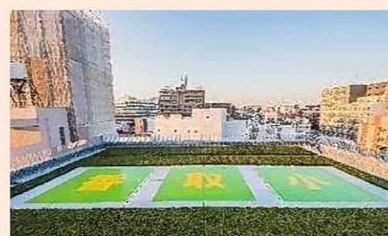
屋上緑化(香取小学校)
