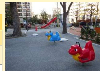
公園改修(扇橋一丁目)
