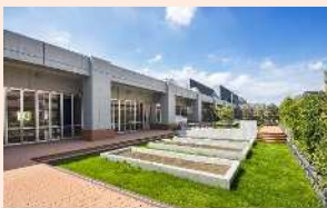
屋上緑化(第二大島中学校)
