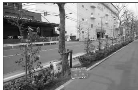
街路樹充実工事後
