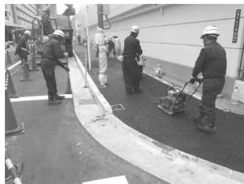
透水性舗装工事の様子
