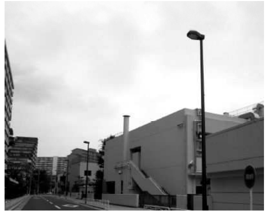
改修後の街路灯（メタルハライド灯）
