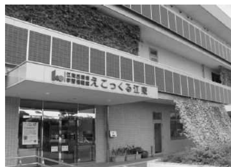
環境学習情報館設置 太陽光パネル
