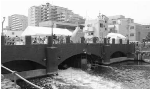
橋の下の発電機
