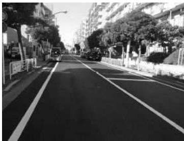
再利用材を使ったアスファルト舗装
