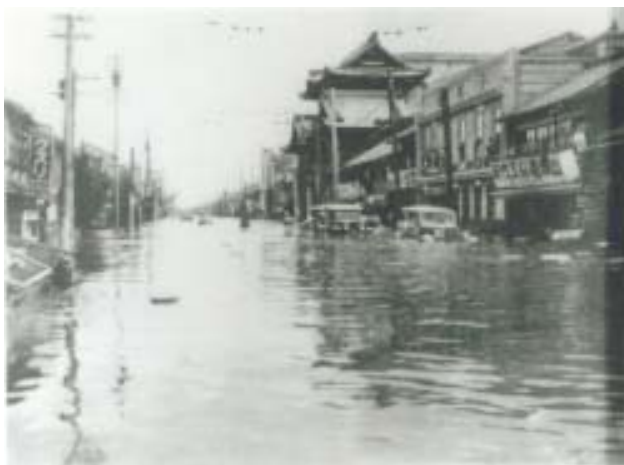
冠水した道路
