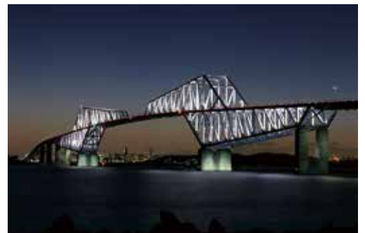
東京ゲートブリッジ Tokyo Gate Bridge
